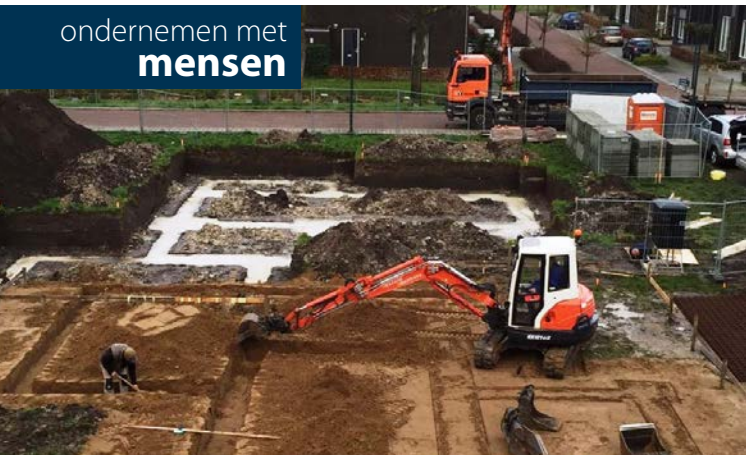
Grondwerken horen ook tot de werkzaamheden. Sprekend voorbeeld hiervan is het precies uitgraven van de fundering voor een nieuwbouwwoning.
