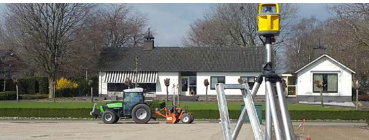
Naast sportvelden legt Donkers ook menig paardenbak aan, waarbij de bak lasergestuurd wordt geëgaliseerd.
